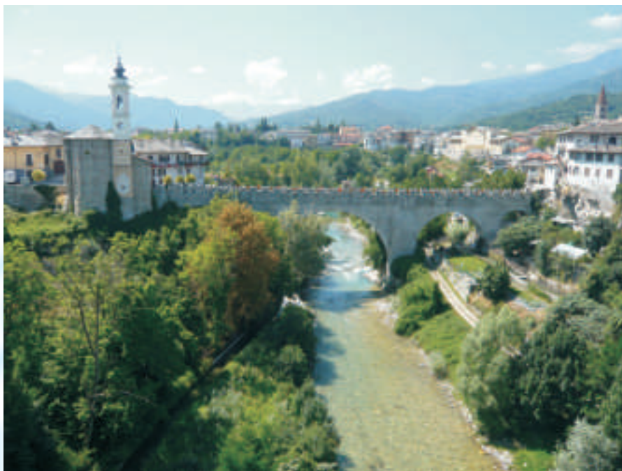
Veduta panoramica con il ponte vecchio che unisce i due versanti dello storico comune
