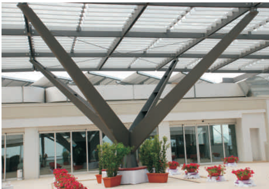
Particolare della struttura congressuale interamente realizzata in vetro e acciaio
